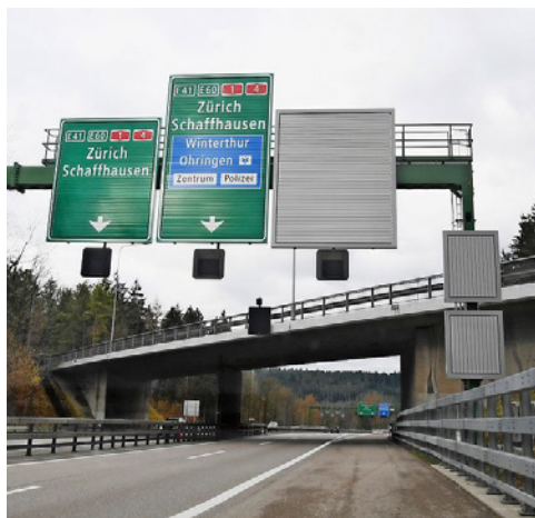
Am Rand der Fahrbahn der A 1 um Winterthur laufen die Vorbereitungen für den grossen Aufbau. Foto: Madeleine Schoder
